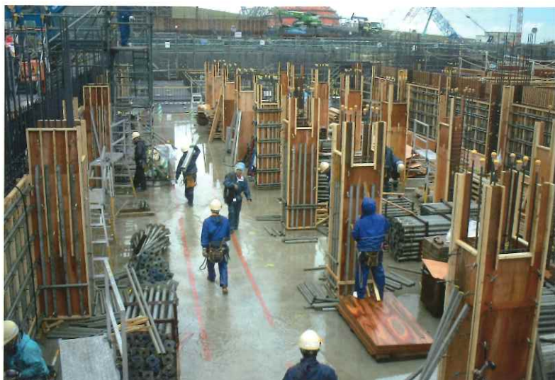
道内の建設現場を支えている
